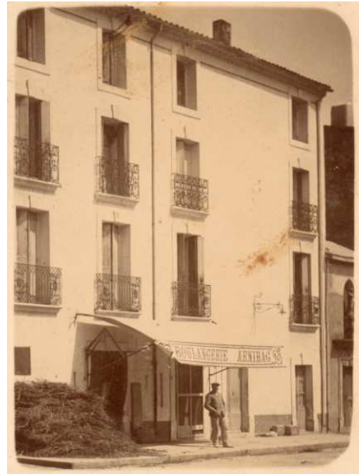
Bois entreposé pour le four de la boulangerie Arnihac
