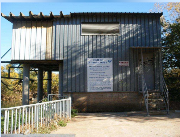
Centrale hydraulique sur l'Hérault
